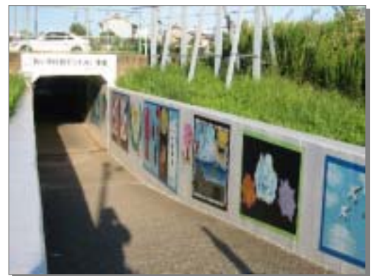
国道153号をアンダーパスする歩道・自転車道
