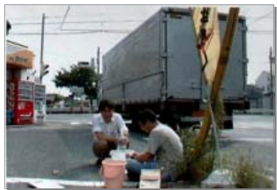
市民による道路環境調査風景
